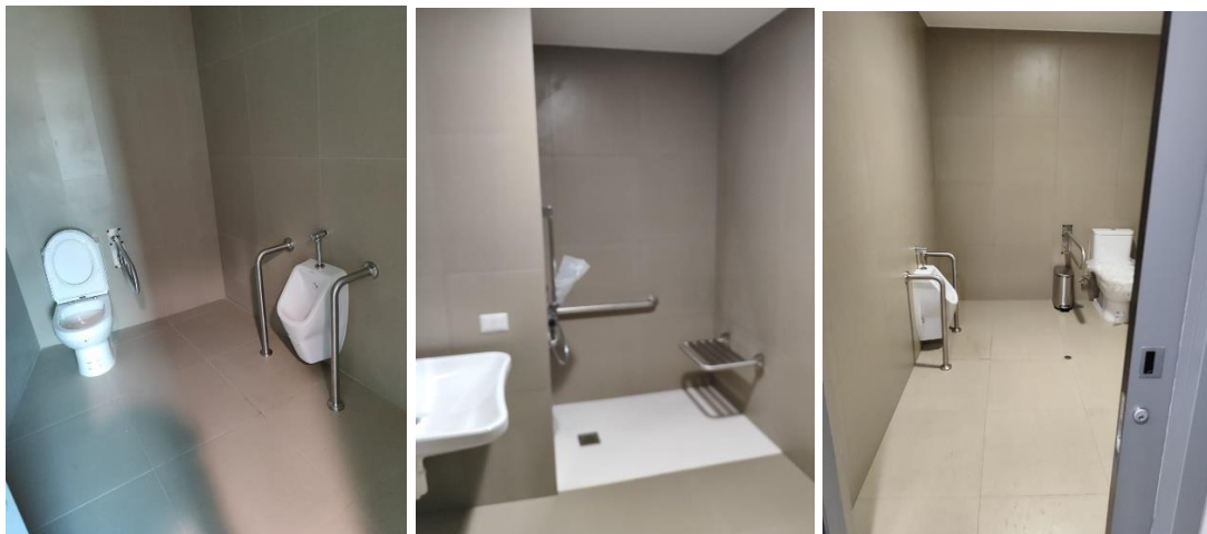
Foto 3,4 y 5. Baños bajos, para discapacitados 1er piso
