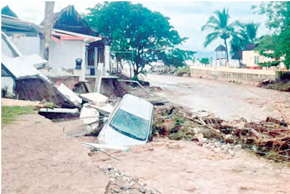
Destrucción en las costas de México por el huracán.
